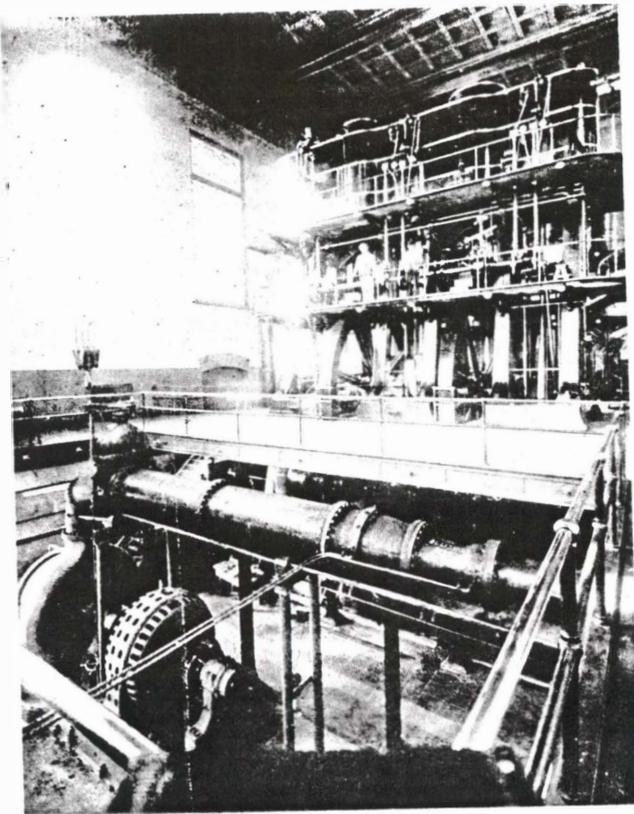
HOLLY TRIPLE EXPANSION STEAM PUMPING ENGINE.
